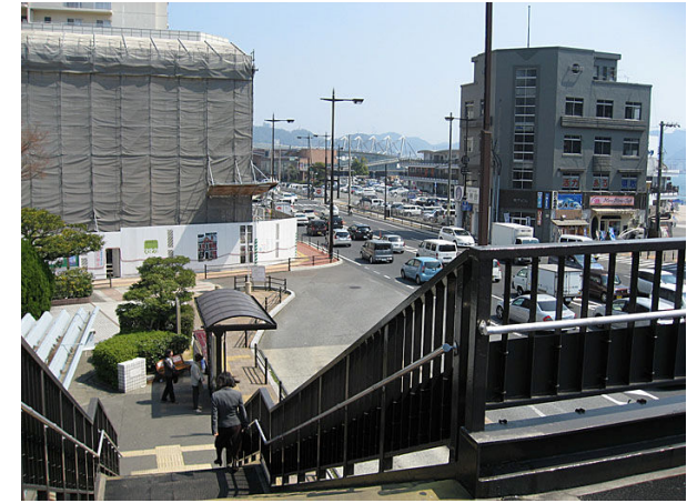
A3：陸橋から見たサテライトキャンパス方向 (左手の工事中ビル“旧英国領事館”の先)
